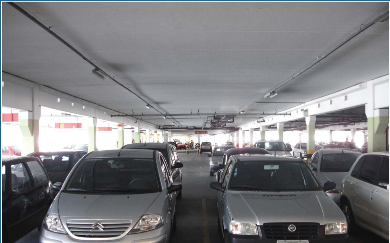
Aplicação dos painéis alveolares em obra - vão livre de 10 m
