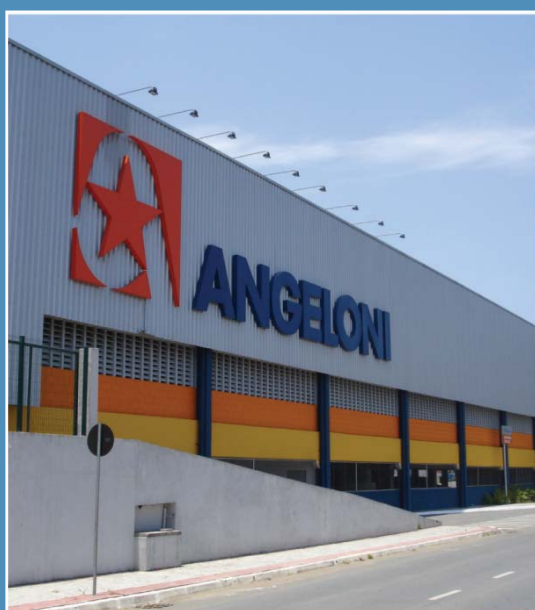
Fornecimento de Laje Alveolar - Supermercado Angeloni - Jaraguá do Sul/SC
