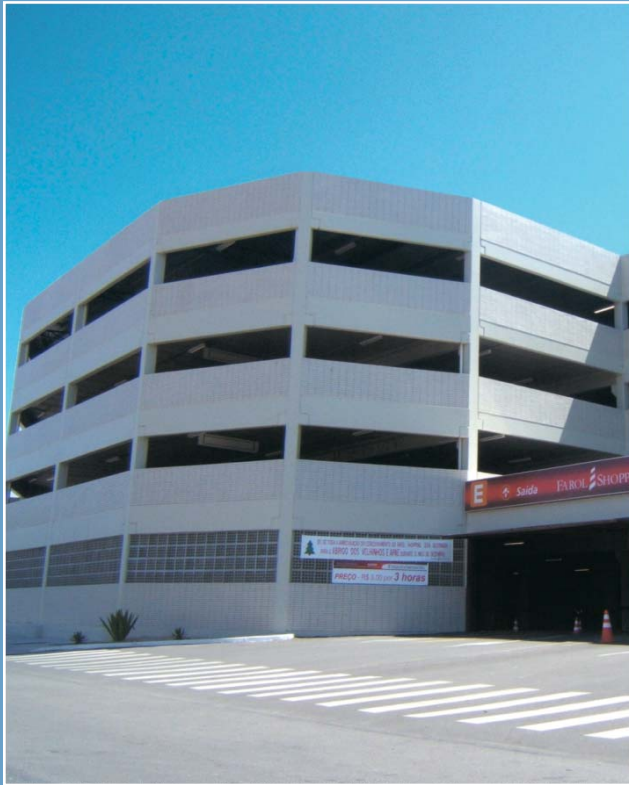
Farol Shopping (edifício garagem) - Tubarão /SC
